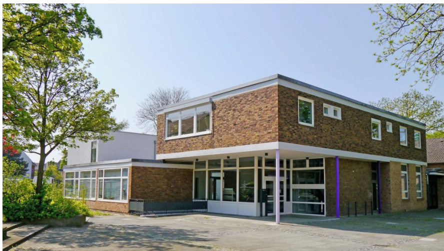
Das neue Bürogebäude für den Evangelischen Kirchenkreis Köln-Rechtsrheinisch in der Wuppertaler Straße in Köln-Mülheim
